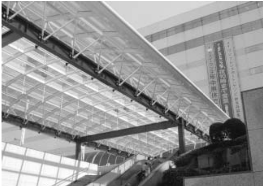
静岡県浜松市：浜松北口駅前広場 シェルター
