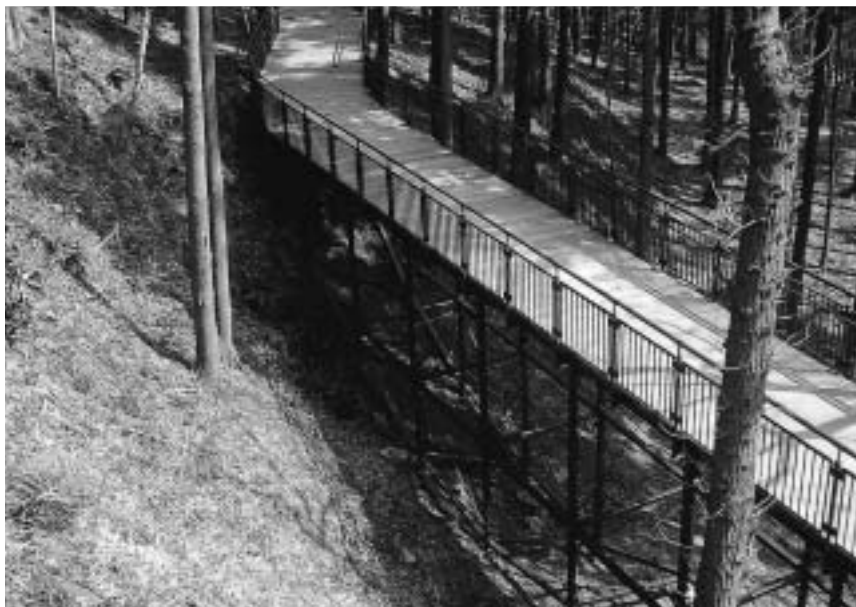
神奈川県津久井郡：津久井湖城山公園 デッキ
