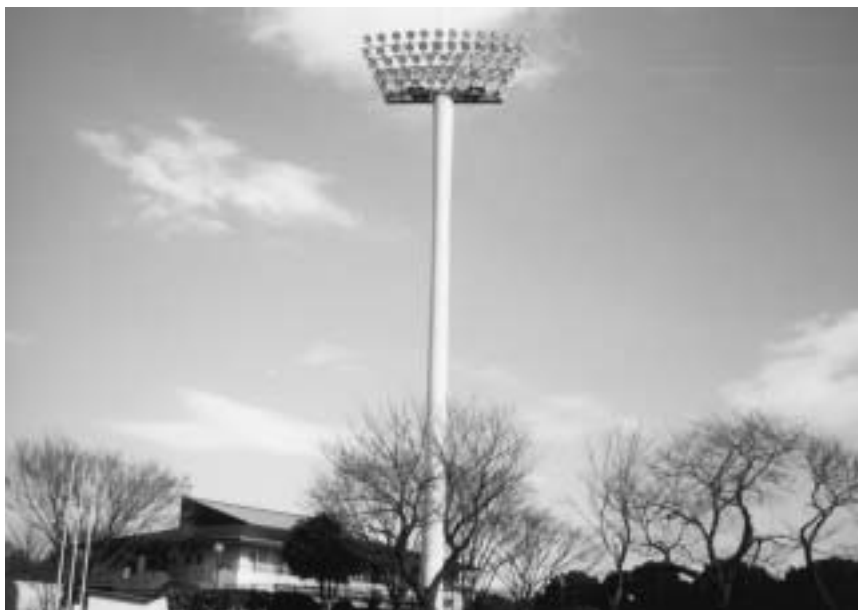
神奈川県横浜市：三ツ沢陸上競技場野球場 照明鉄塔
