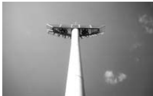
神奈川県横浜市：三ツ沢陸上競技場野球場 照明鉄塔
