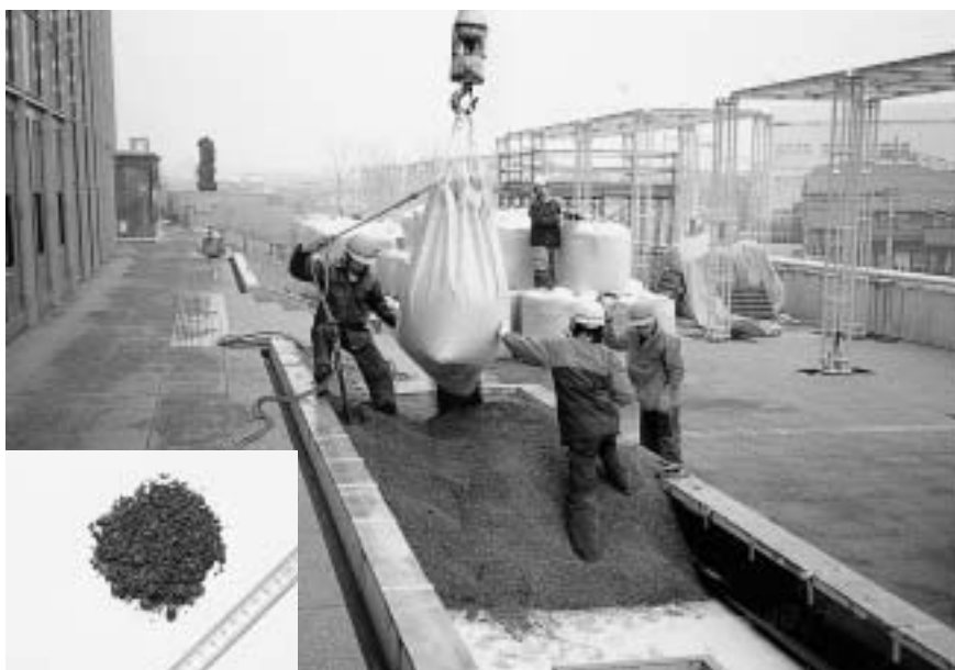
ビバソイル敷均し状況
