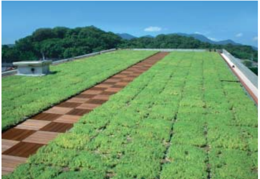
松尾製菓（チロルチョコレート）福利厚生棟施設をプリオセダム トレー工法にて施工
