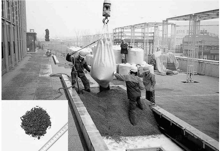
ビバソイル敷均し状況
