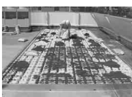
人工土壌の敷き均し
