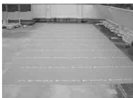
耐根シートの設置
