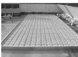
格子基盤の設置
