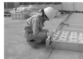
土留めパネルの設置
