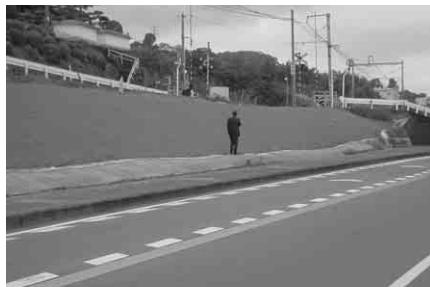
鉄道法面防草
