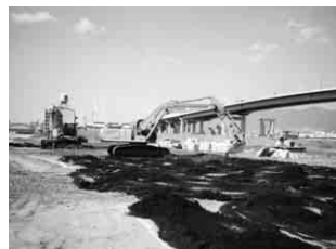
施工中の様子
