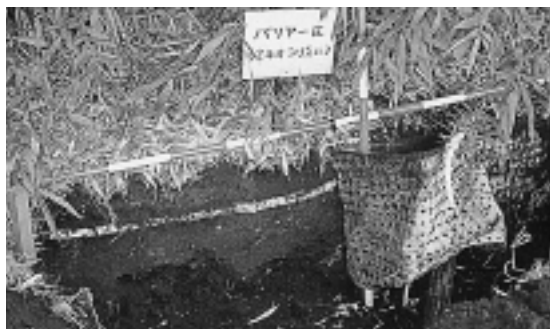
竹の地下茎の根止め
