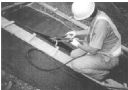
例) トーチバーナーによる加熱融着工法
