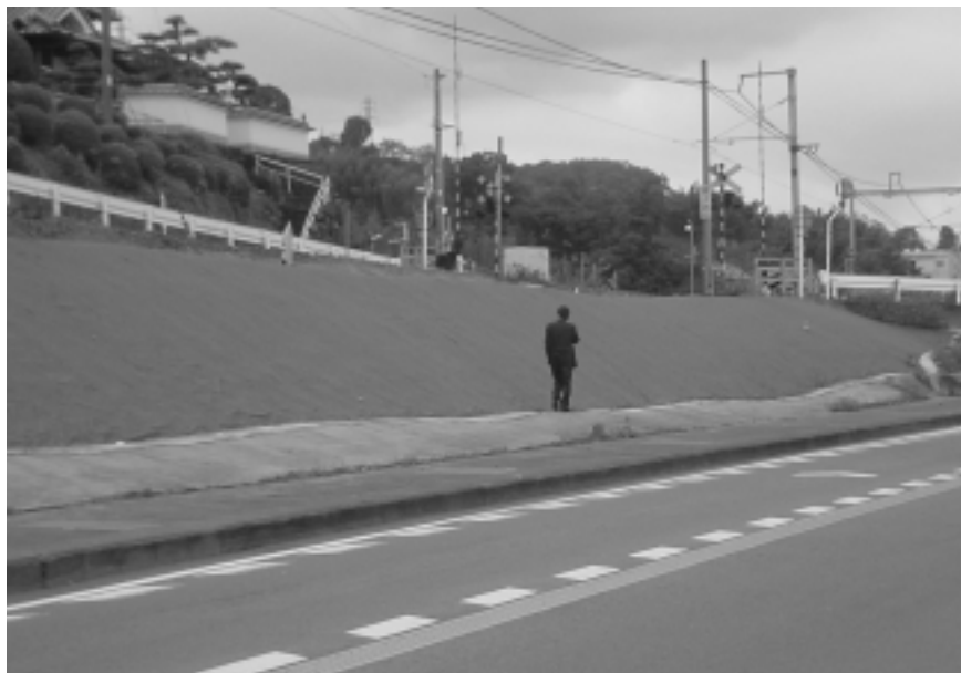
鉄道軌道法面防草施工例
