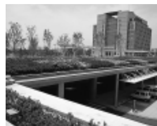
駐車場の上部緑化
