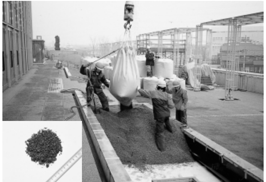
ビバソイル敷均し状況
