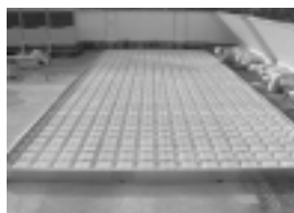
格子基盤の設置
