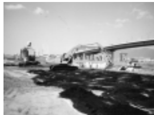
施工中の様子
