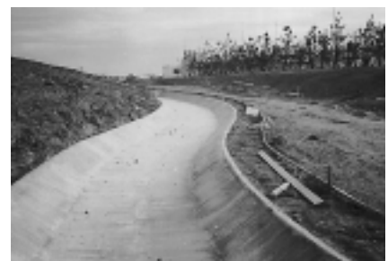
TMCモルタルの塗り込みおよび表面仕上げ
