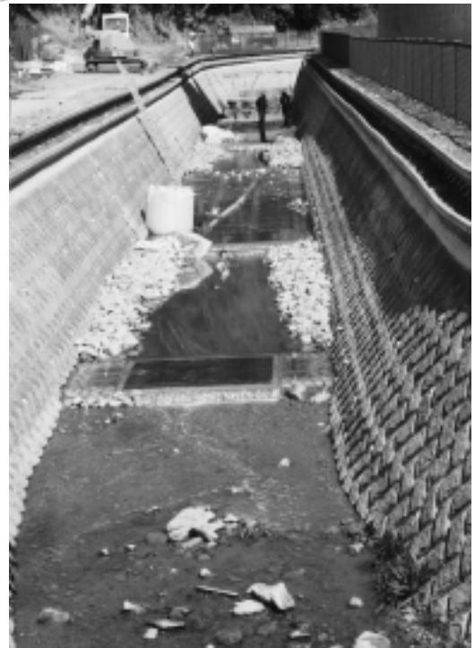
河川浄化（横須賀市）
