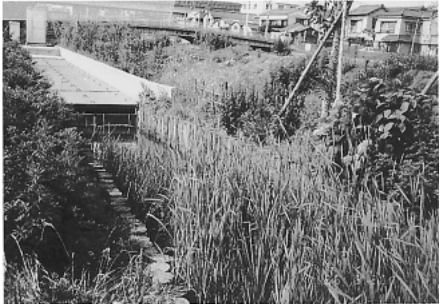
CB濾材による水質浄化槽
