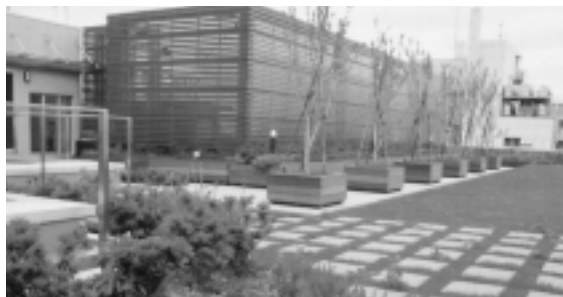
●内野ビル屋上（東京都中央区）
