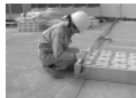
土留めパネルの設置
