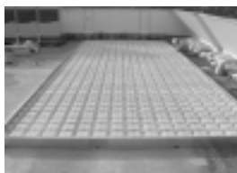
格子基盤の設置
