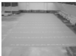
耐根シートの設置
