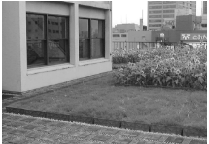
東京都文京区『講道館』（屋上緑化システム：コアブロック）
