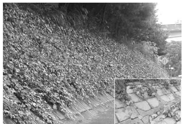
コンクリートのり枠部で客土入り土のうを併用した地被植栽例 (ヘデラカナリエンシス)
