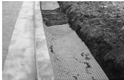
2. 水平敷設法 垂直に侵入する根茎を制御する。
