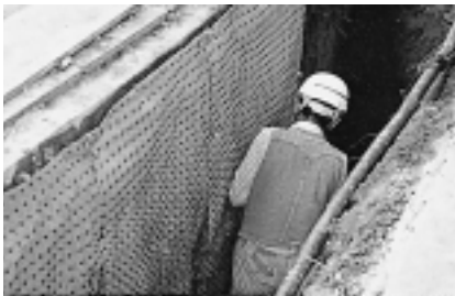
1. 垂直施工方法 横方向に侵入する根茎を制御する。
