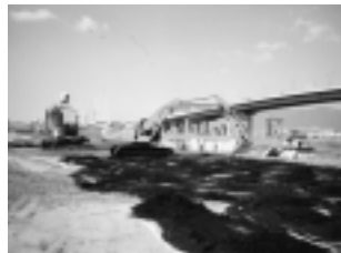
施工中の様子
