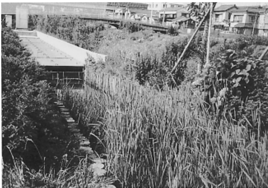
CB濾材による水質浄化槽
