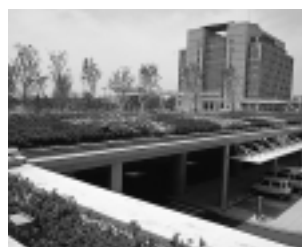
駐車場の上部緑化
