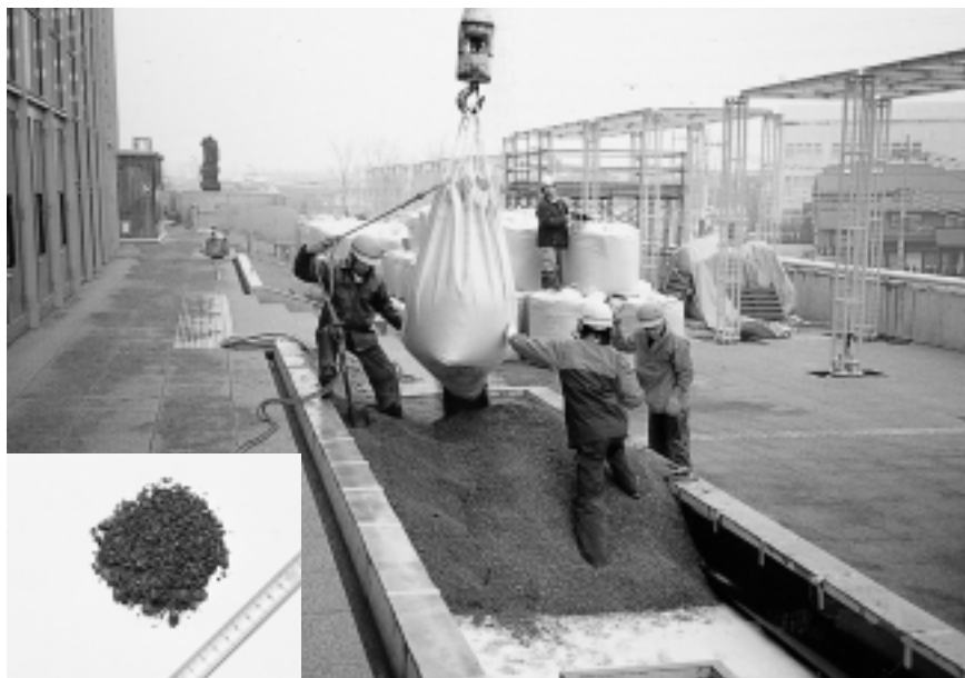
ビバソイル敷均し状況
