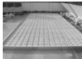
格子基盤の設置
