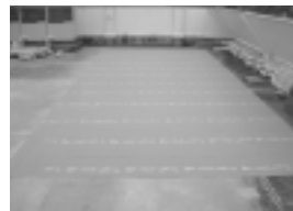
耐根シートの設置
