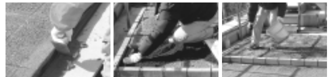
4. モルタル止め 5. 切り芝貼り(土で不陸調整) 6. 目土散布
