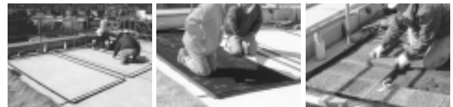
1. 施工位置出し 2. 防根シート敷き 3. 基盤敷設(砂でガタツキ防止)
