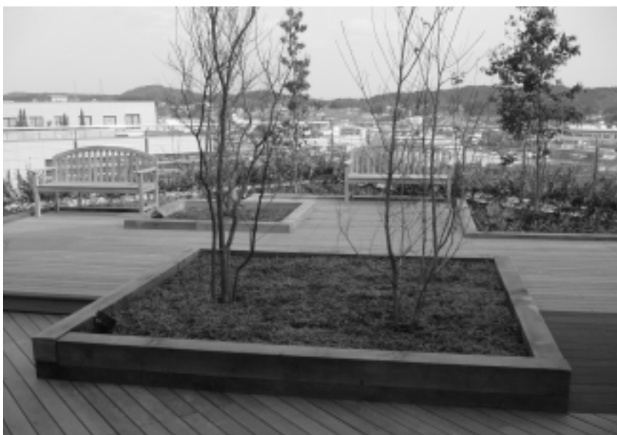
津山中央病院 カリフォルニアレッドウッド縁切り材
