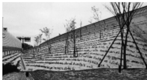
ハイテクマルチングパネル 施工時(ヘデラヘリックス5株/m) 東京外環自動車道、大泉IC
