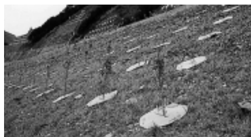
EPOマルチングボード、マーカーポール施工例
