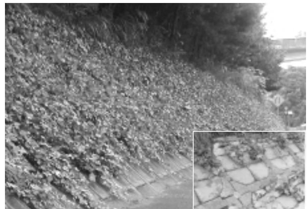
コンクリートのり枠部で客土入り土のうを併用した地被植栽例 (ヘデラカナリエンス)
