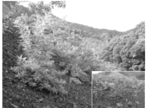
乾燥の激しい岩砕盛土部への植栽に利用 (施工後1年)
