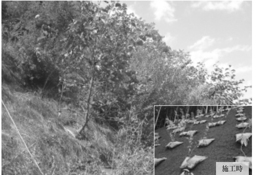
厚層基材吹付切土のり面 (1:0.8勾配) への苗木植栽例 施工後2年
