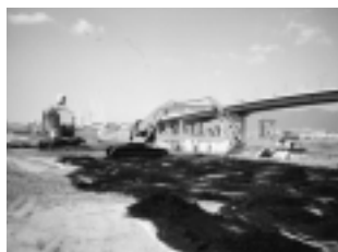
施工中の様子
