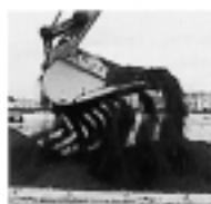
エコ炭攪拌状況 (飛散しにくい)
