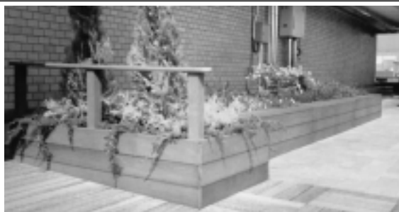
●品川区総合庁舎屋上（東京都品川区）
