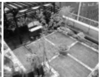
オフィスビルの屋上緑化
