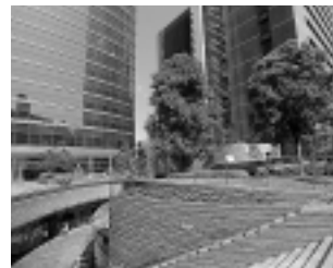
ビル外構の人工地盤緑化
