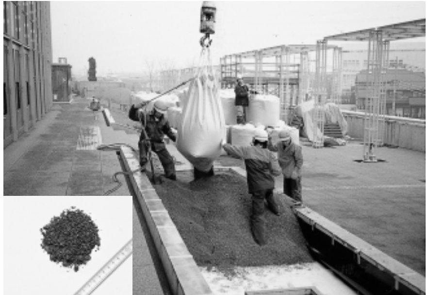
ビバソイル敷均し状況
