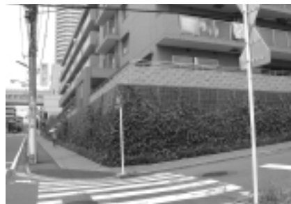
住宅地のコンクリート擁壁 歩道側のコンクリート擁壁面の修景に 利用（神奈川県横浜市）
