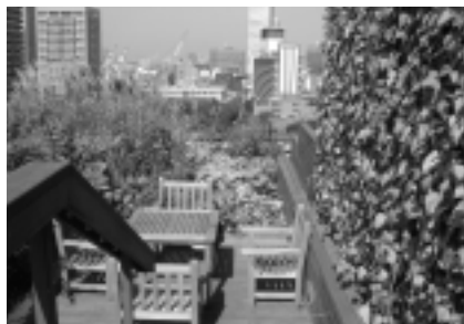
マンション屋上のフェンス 屋上室外機の目隠しとして利用 （東京都港区）
