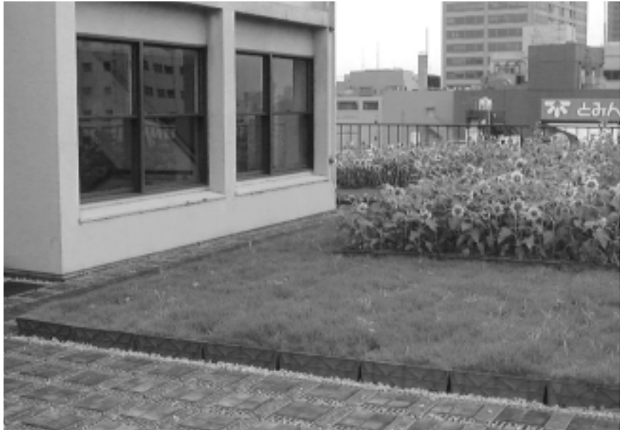
東京都文京区『講道館』（屋上緑化システム：コアブロック）
