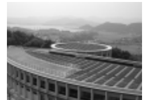
研修棟建屋の屋上
