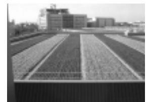
事務本館の屋上
